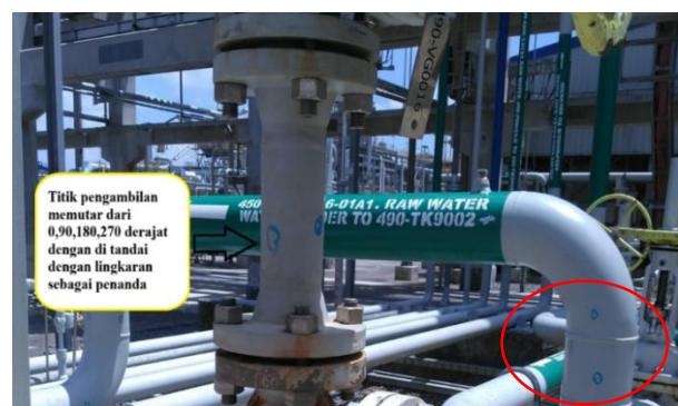
Gambar 6. Pipa yang Diukur Ultrasonic Test
